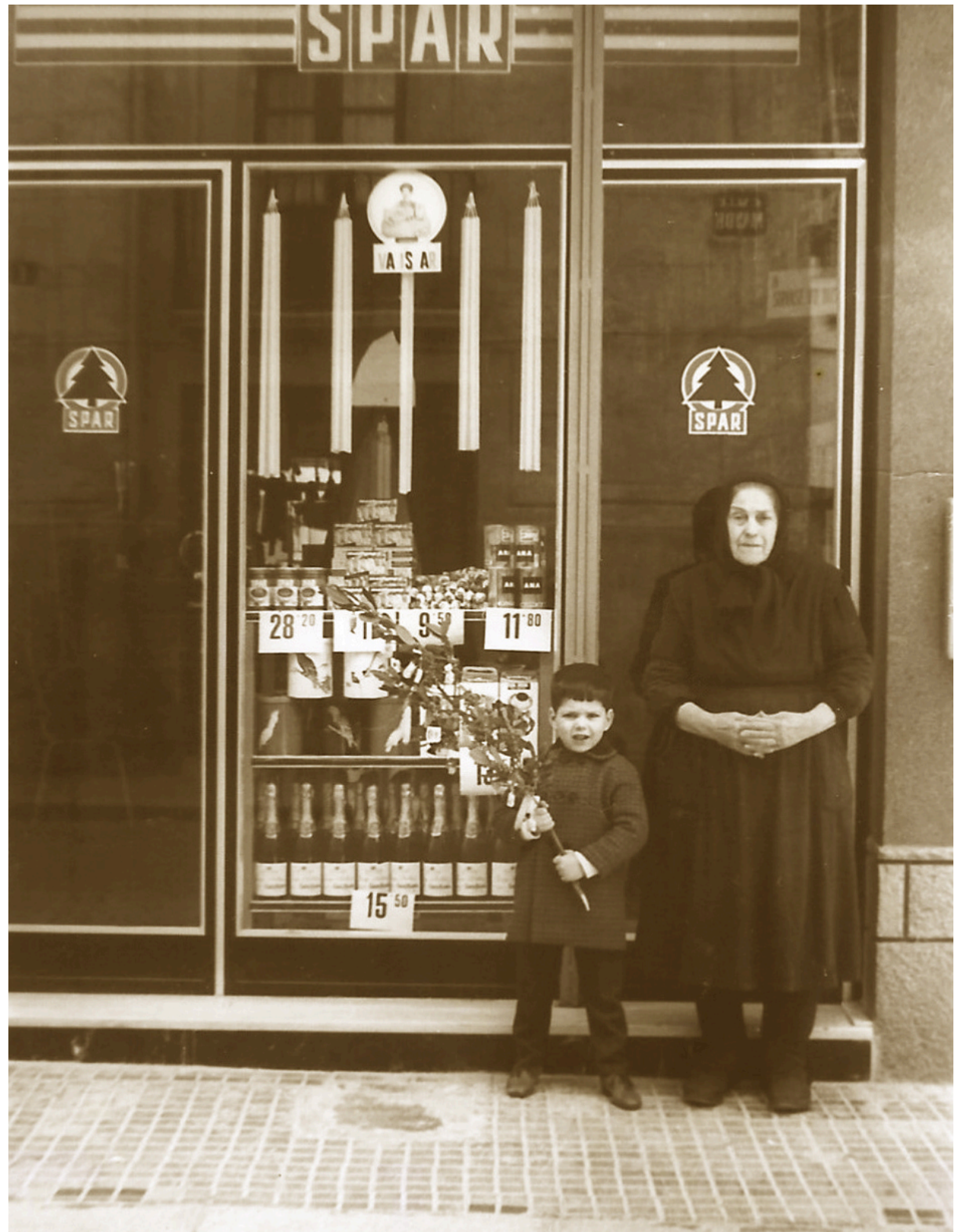
Pepa i Oscar davant de la Botiga, a l'aparador es veuen les candeles penjades. Foto feta després de les obres de reforma de l'edifici.
