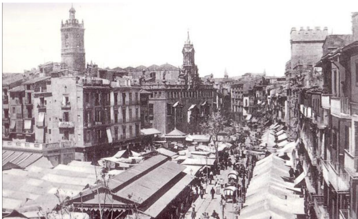
Al centre de la foto es veu el Mercat construït el 1840, envoltat de nombroses parades ambulants.
