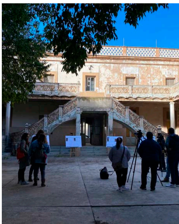
La rehabilitació preveu deixar l'antic pati com un espai públic obert al carrer
