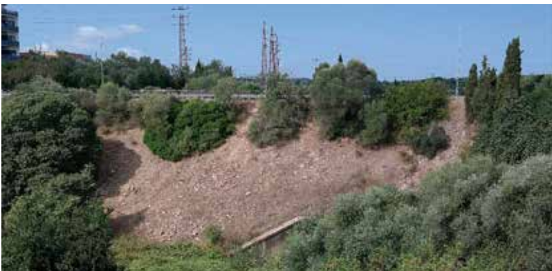
El terraplé que es va fer per salvar el barranc de les Comes.
