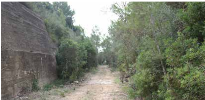
Al llarg del recorregut es construïren diversos contraforts, per protegir la via de possibles esllavissades.
