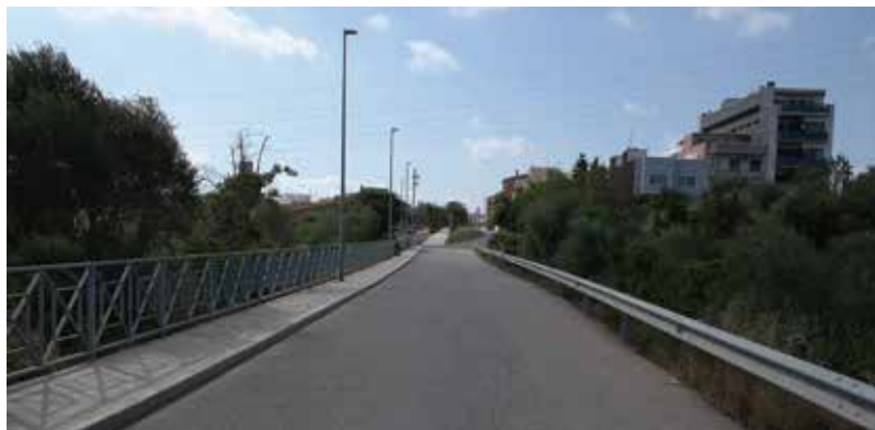
La carretera sobre el barranc de les Comes.
