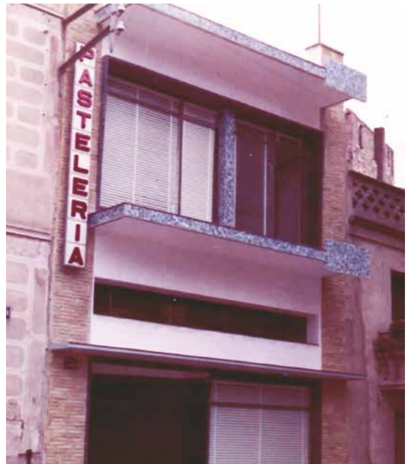
Façana de la pastisseria al carrer sant Isidre, encara en construcció (1964)
