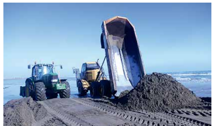
Pla general dels treballs per restablir un camí de pas després del trencament de la barra del Trabucador pel pas del Filomena. Imatge del 18 de gener de 2021.
