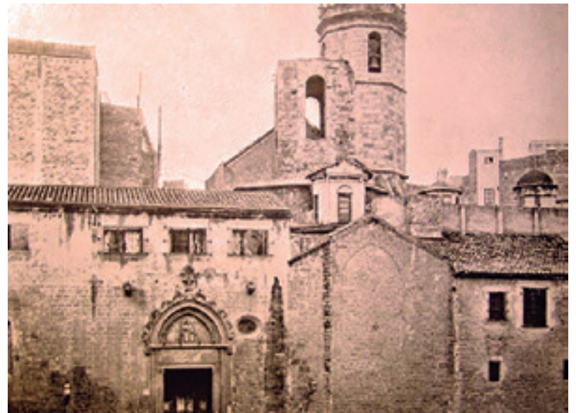
Façana principal del Convent de Santa Caterina, del segle XIII.
