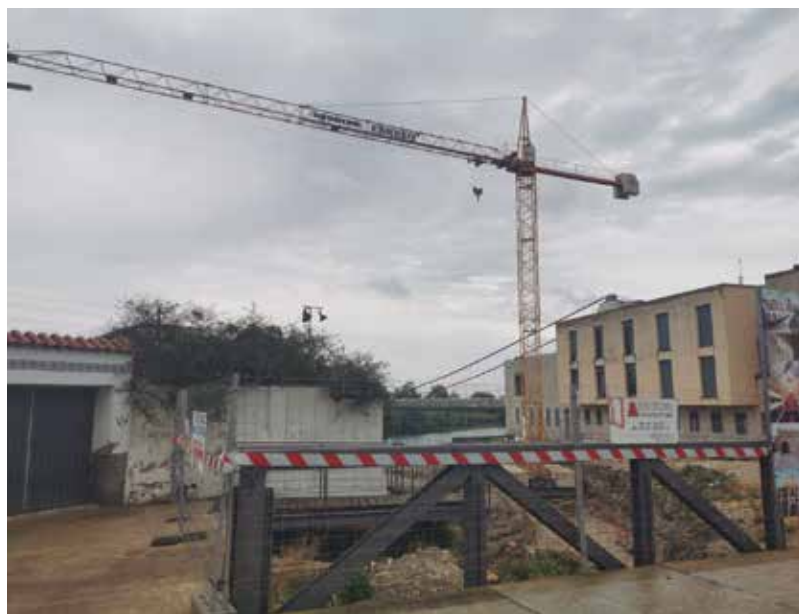
Les obres de recuperació i posada en valor de la celòquia tenen un pressupost de 600.000 euros.
