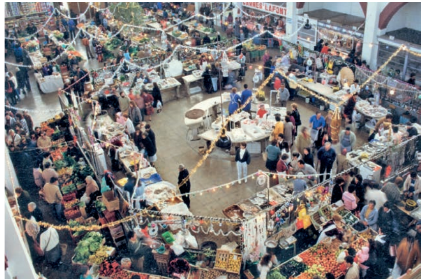
Zona del peix abans de la reforma de 1994.
