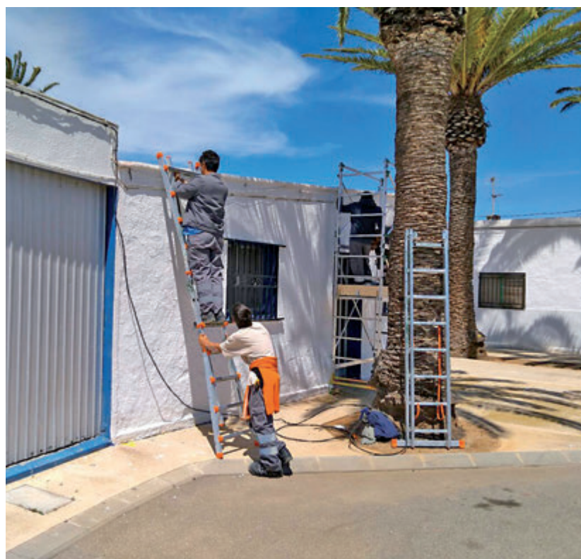
Els joves van arranjar les instal·lacions i van instal·lar les noves lluminàries.
