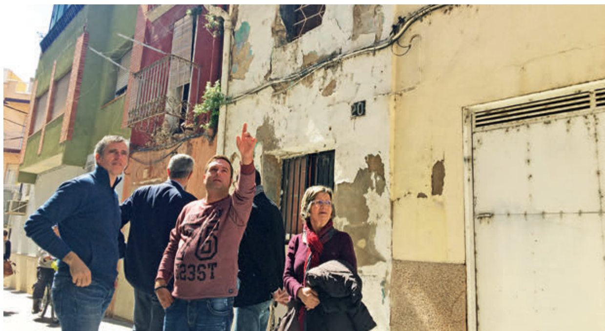
L'alcalde amb el president del barri de la Vila, al carrer Sant Roc, on s'obrirà en un espai públic.
