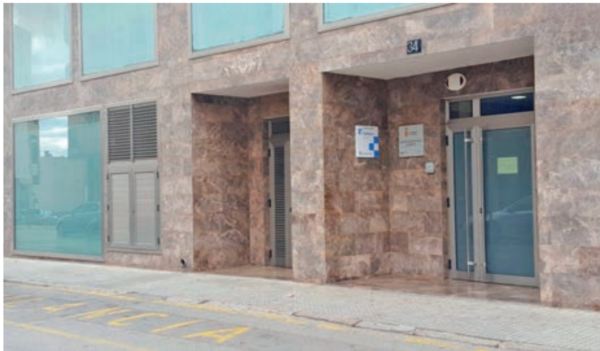
El centre de rehabilitació està ubicat a l'avinguda Catalunya 66-72
