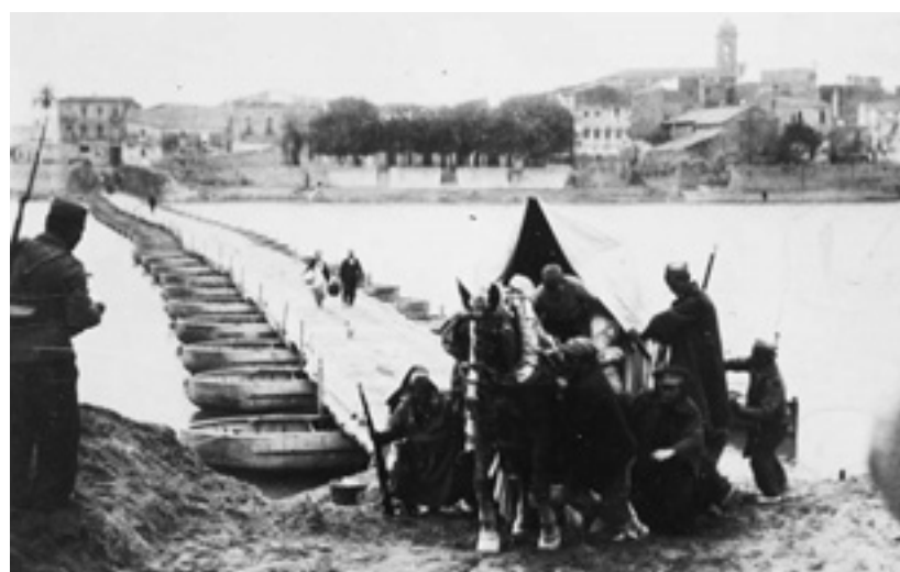
Pont de barques durant la Guerra Civil, després que es destruís el pont.
