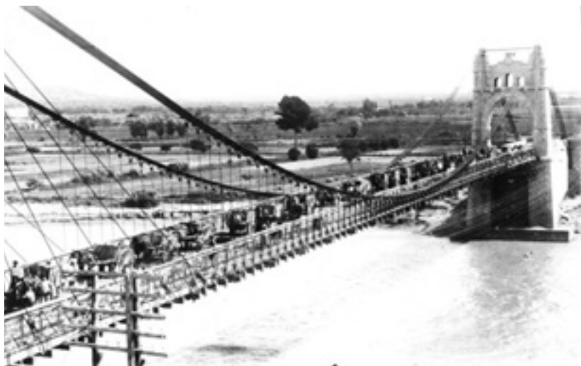
44 carros van creuar el pont per fer-ne la prova de resistència.
