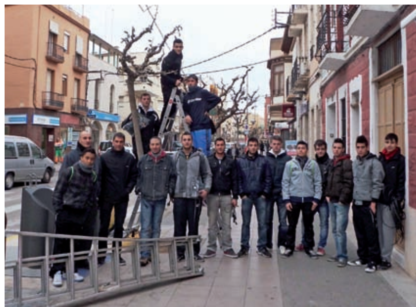
Alumnes de l'Institut Montsià fent la instal·lació.
